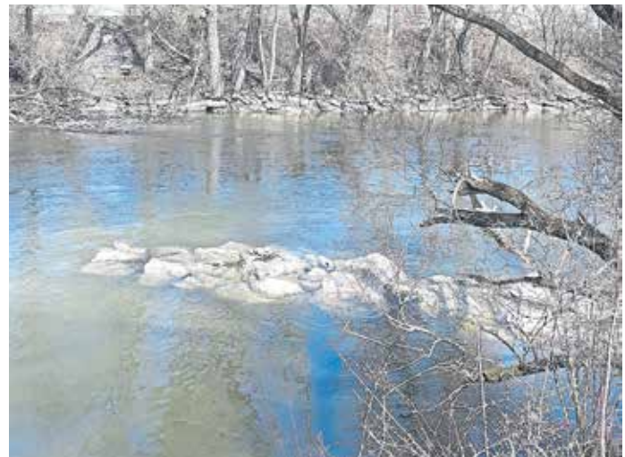
Neues Bühnenfeld mit Totholz an der Amper
