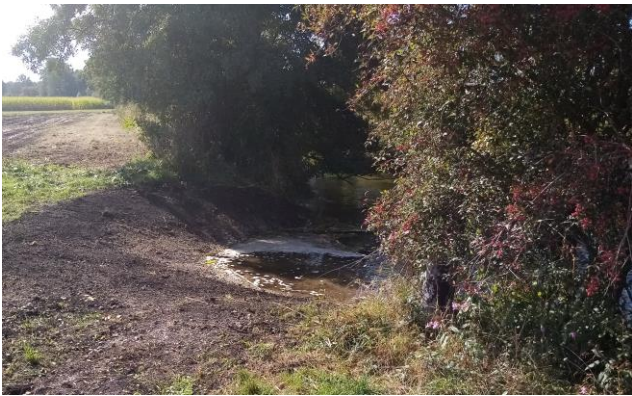
Abb. 2: Vermoorte Mulde und Ufer - Aufweitung mit tiefer Gumpe
