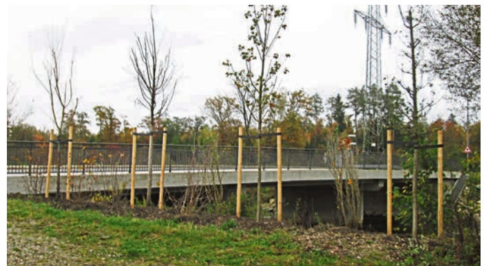
Pflanzung neben der neuen Brücke an der Torstraße
