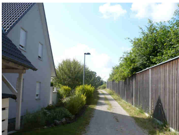
Bild 2 bestehende Wohnbebauung und Lärmschutzwand im Norden
