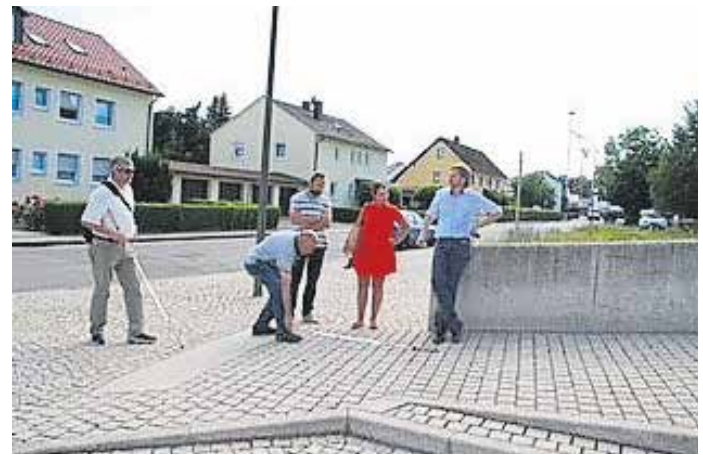
Rathaus: Kopfsteinpflaster, kein automatischer Türöffner, Treppentufen ohne farbliche Markierungen
