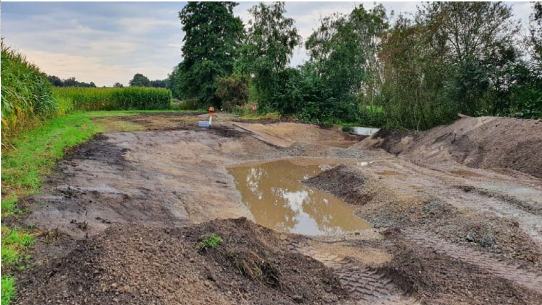
Kalterbach – Renaturierung soll nun vom Feldmochinger See bis Einlauf Amper als Pilotprojekt durchgeführt werden durch Dachauer Moosverein.
