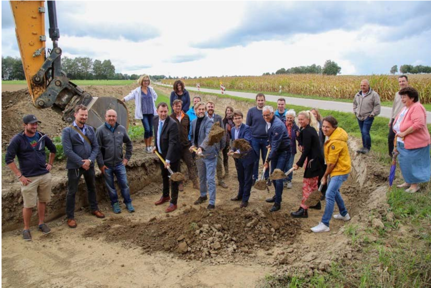
Spatenstich mit Beteiligten Kommunen, Wasserzweckverband, Gemeinderäte, Planer und Firmen September 2022
