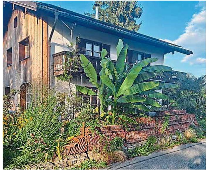
zuordnen, und daraus mit höchster Präzision eine Trockenbaumauer auf den Trümmern der Alten Garage zu errichten. Diese bepflanzte er mit Mauerpfeffer, Kakteen und anderen Sukkulenten. In den mit Sand-Kiesgemisch verfüllten Zwischenräumen bildeten sich neue Lebensräume für allerlei Insekten und sogar Wildbienen leben in der Mauer aus Dachziegel. Im Folgenden präsentiere ich Ihnen einige Impressionen von der Dachziegelmauer vom „Sommer-Haus“ aus Breitbrunn.
