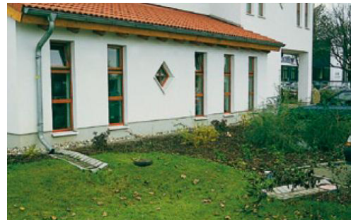
Abbildung 4-2: Ableitung Fallrohre mit Zeilerrinne, Quelle: LfU
